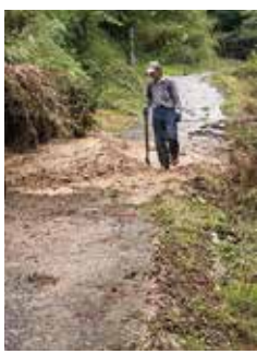
農道に流出する土砂
